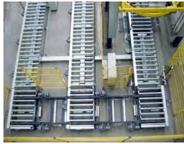
Komplexes Logistiksystem mit Palettenstretchanlage für Dachser, Deutschland.
